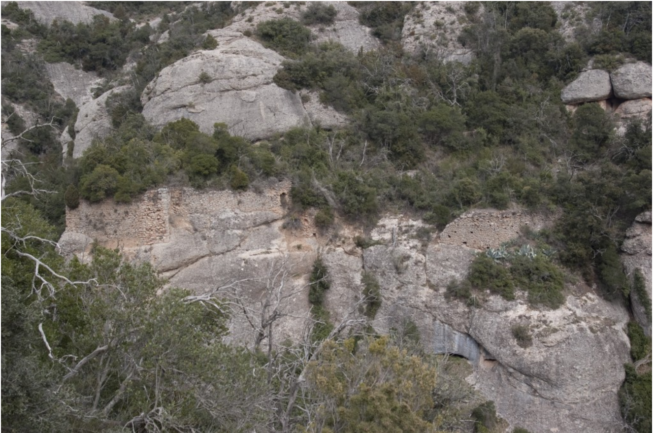
Ermita de santa Anna. Situació abans del desbrossament.
