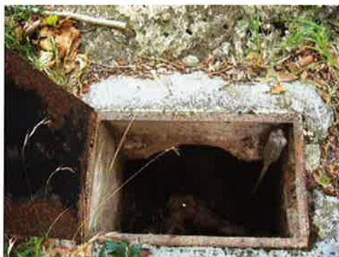
Detall de la cisterna que hi ha darrere la font, amb diversos tubs de canalització
