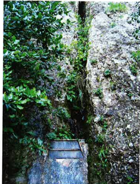
Detall de l'esclotxa que recull l'aigua a la cisterna, abans del broc de la font pròpiament dita
